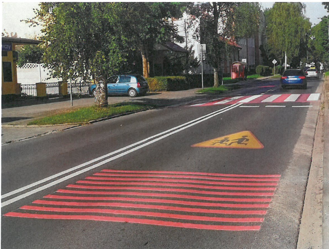
Fotografia nr 5 – przykładowe pasy akustyczno-wibracyjne
