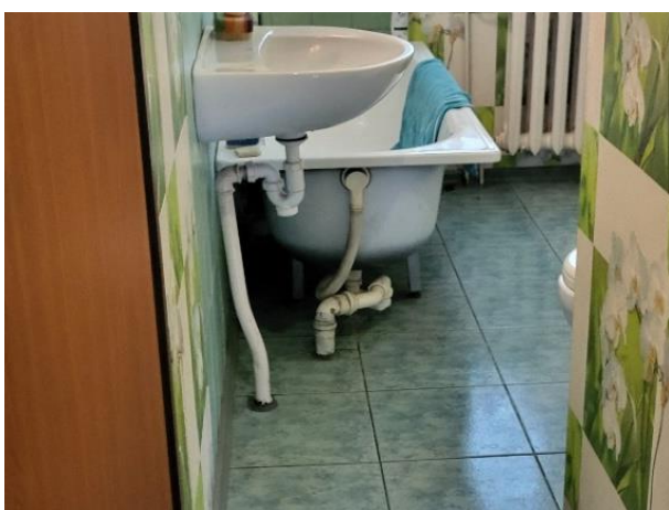
Pomieszczenie przed likwidacją barier architektonicznych
