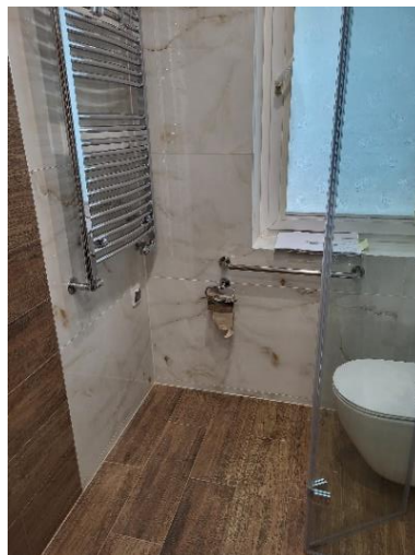
Pomieszczenie po likwidacji barier architektonicznych
