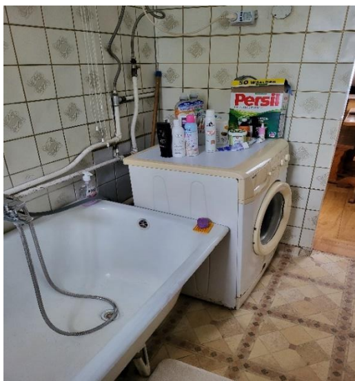
Pomieszczenie przed likwidacją barier architektonicznych
