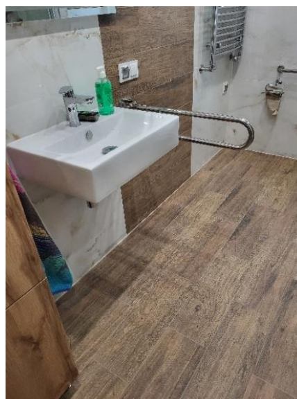
Pomieszczenie po likwidacji barier architektonicznych
