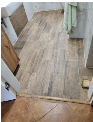
Pomieszczenie po likwidacji barier architektonicznych
