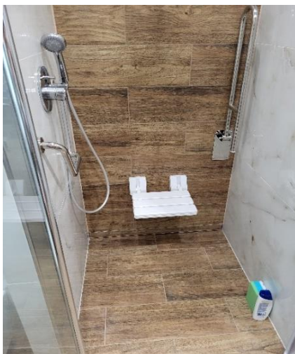
Pomieszczenie po likwidacji barier architektonicznych
